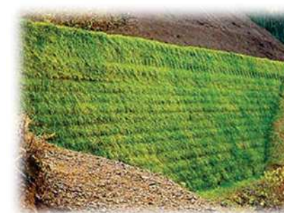
例：補強土壁工
